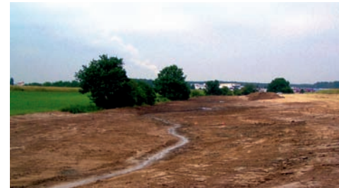
Hirtengraben vorher (oben) und während der Bauphase (unten)
