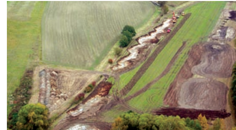
Luftbildaufnahme während der Bauphase
