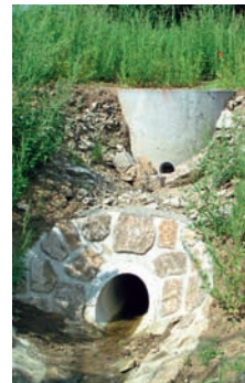
Absperrbauwerk für Rückhaltung
