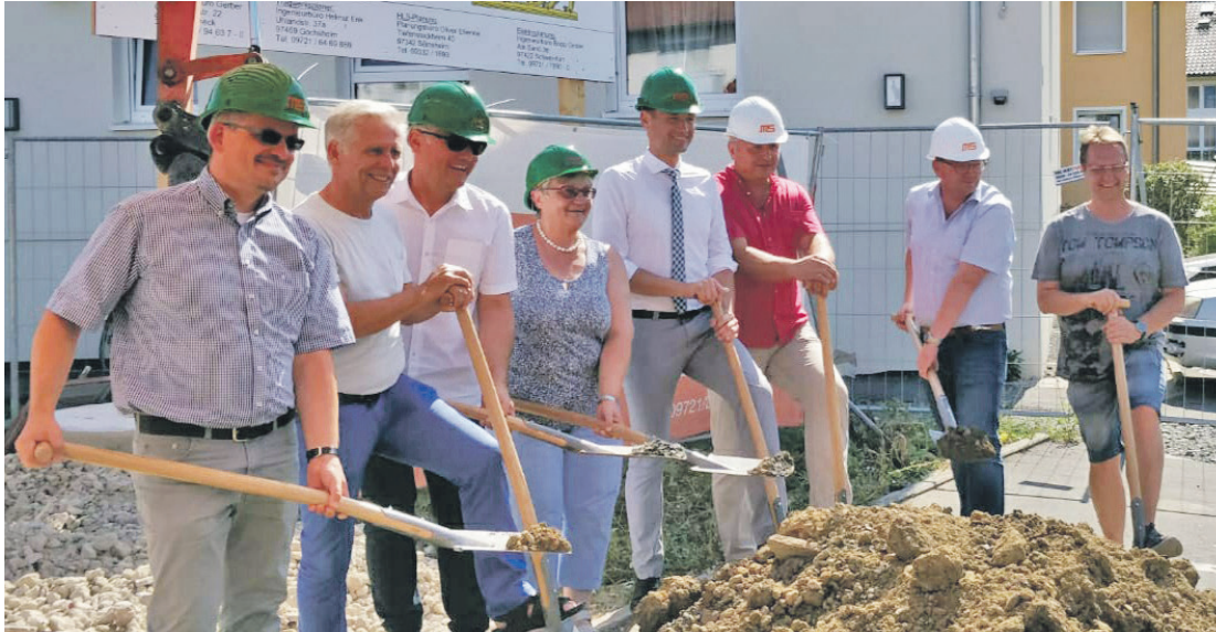
Im Bild von links nach rechts: Geschäftsleiter Udo Böhnlein, Bauamtsleiter Manfred Scholl, Architekt Benedikt Gerber, Erste Bürgermeisterin Helga Fleischer, Landrat Florian Töpfer, Bauleiter Robert Hümpfner Fa. Siebenson, Geschäftsführer Thomas Siebenson Fa. Siebenson, Bauleiter Jürgen Meder Architekturbüro Gerber Foto: C. Konrad
