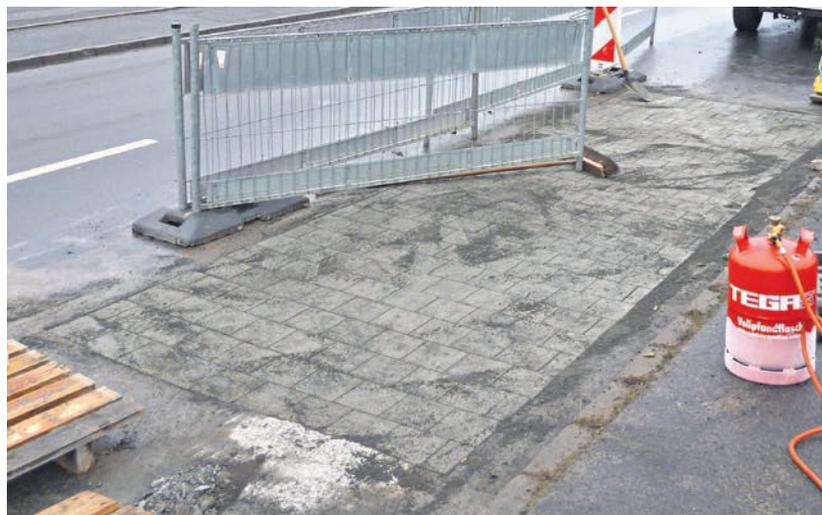
In der Industriestraße zwischen Einmündung EDEKA Lager und Kreisverkehr Kreisstraße wurde die Gefahrenstelle – Asphaltaubruch – provisorisch mit Pflastersteinen instandgesetzt. Sobald die Asphaltwerke wieder geöffnet haben
