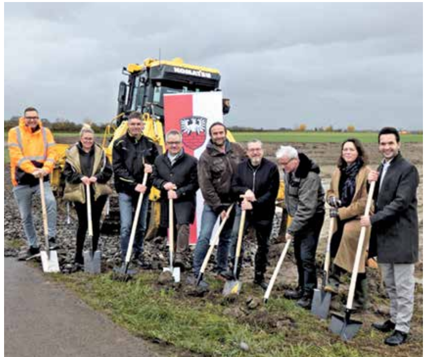
Offizieller Spatenstich für das Baugebiet Gochsheim Südost II. Von links: Thomas Schäflein, Antonia Riedlmeier (beide NEWO), Martin Barthelme (Hoch- und Tiefbau Müller Gerolzhofen), Geschäftsleiter Udo Böhnlein, Gemeinderatsmitglied Peter Matl, Gemeinderatsmitglied Werner Hoyer, Lothar Meißner (FMP), Mareile Kästner (BayernGrund), Erster Bürgermeister Manuel Kneuer.
